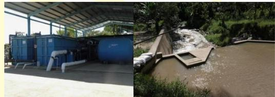
Detalló que las obras de progreso consistieron en la construcción de un dique-toma en río Escambray; instalación de 27 kilómetros de tuberías de la línea de conducción y redes de distribución; 2 tanques de almacenamiento vitrificados con una capacidad total de 2,814 metros cúbicos; y una Planta de Tratamiento de Agua Potable que procesa 66 litros por segundo. Estos trabajos tuvieron una duración de 21 meses y generaron 700 empleos directos e indirectos.
